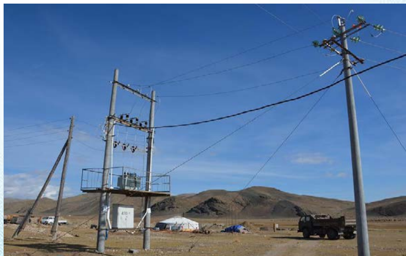
Төвийн эрчим хүчний шугамд холбогдож гэрэл цахилгааны асуудал бүрэн шийдэгдэв. 80 сая төгрөгний өртөг бүхий гудамжны гэрэлтүүлэг камержуулалтын ажил хийгдлээ.
