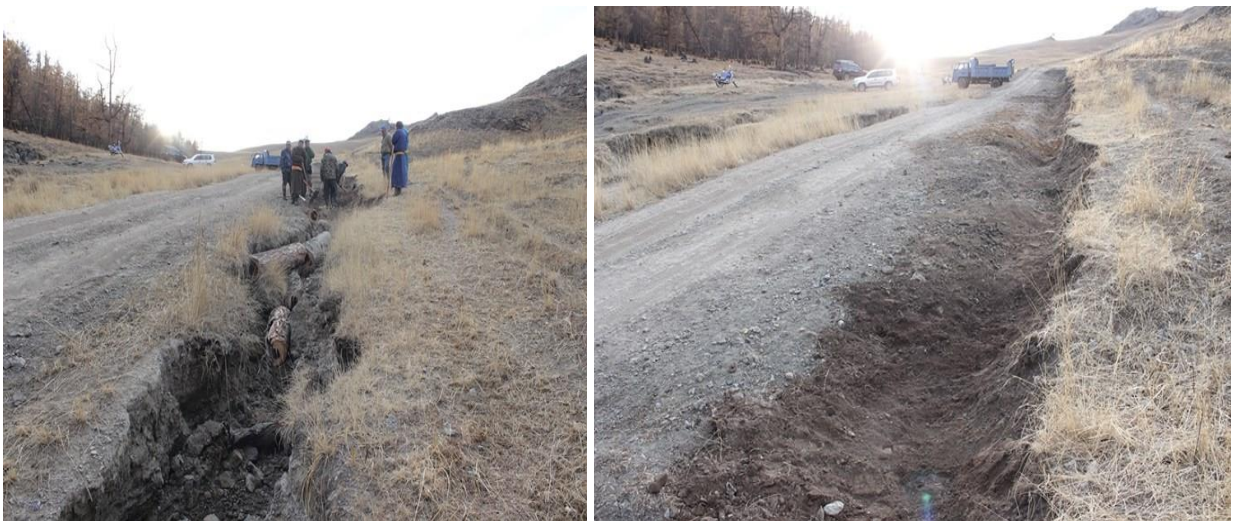
Зураг 21:22: Суурьтын дөрөлжний зам өмнөх болон зассаны дараах байдал
